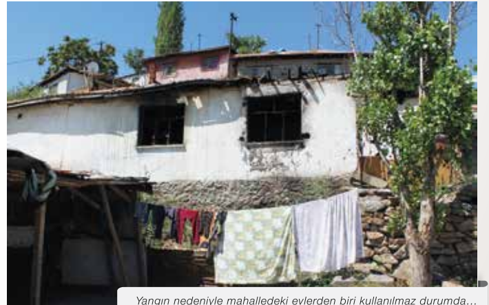
Yangın nedeniyle mahalledeki evlerden biri kullanılmaz durumda...
